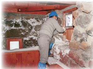
(写真12) 窓の補修作業
